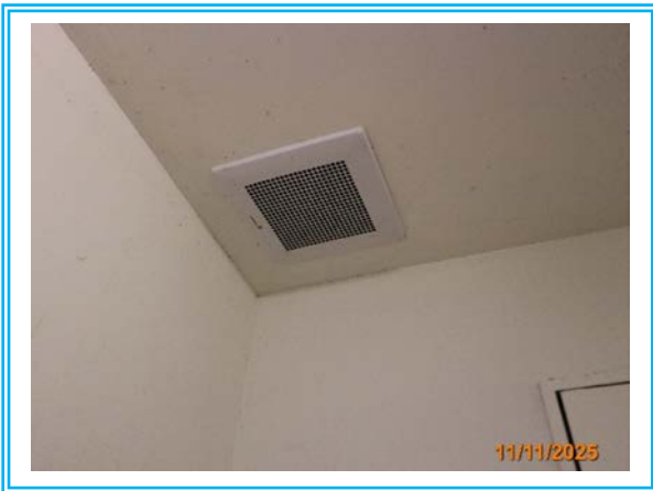
รูปที่ 3-38 พัดลมดูดอากาศภายในห้องพักขยะเปียก
